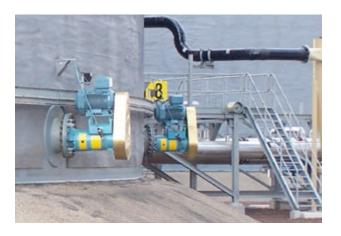
Die Horizontalrührwerke werden im Normalfall in Behälter mit großem Durchmesser eingebaut. Sie müssen in der Lage sein, einen ausreichend kräftigen Flüssigkeitsstrahl zu erzeugen, um die entgegengesetzte Wand des Behälters zu erreichen.
