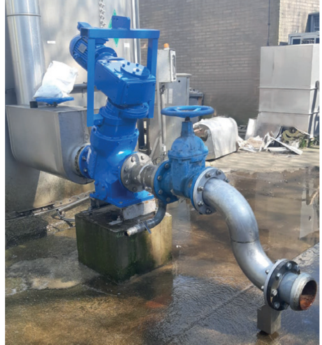
Het innamepunt voor extern slib, bij RWZI Elburg, met de nieuwe NOV Mono TR Muncher.
