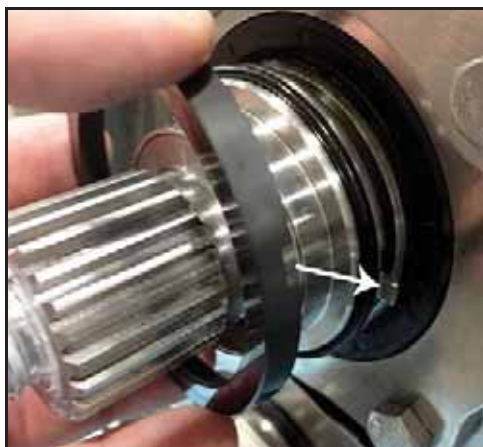
Figure 105 – Installation de la garniture rotative côté rinçage
